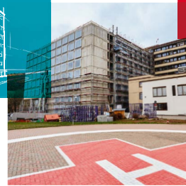
Bei der Erweiterung des Klinikums Kulmbach setzten die Profis von F. K. Isoliermontage auf Teclit von ROCKWOOL
